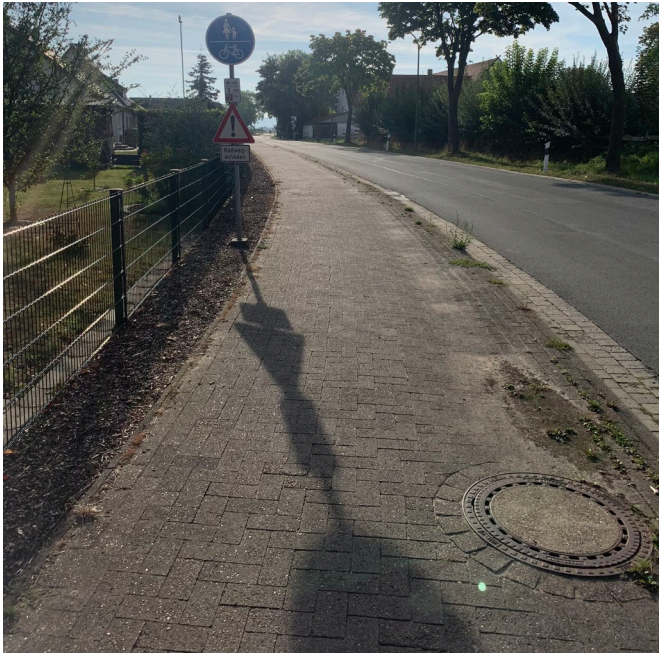
Abbildung 64: Radweg an der K 409, Ortsteil Hüsedede
